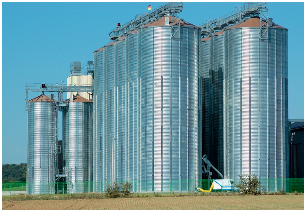
Drehflügel-Füllstandanzeiger der DF-Serie mit Atex-Zulassung überwachen zuverlässig den Füllstand in vielen Getreidesilos
