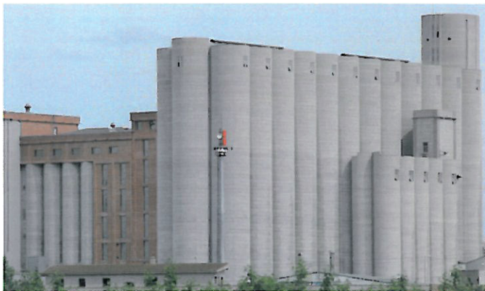
Abb. 1: Drehflügel-Füllstandanzeiger der DF-Serie überwachen zuverlässig den Füllstand in unterschiedlichsten Getreidesilos, auch in explosionsgefährdeten Bereichen.
